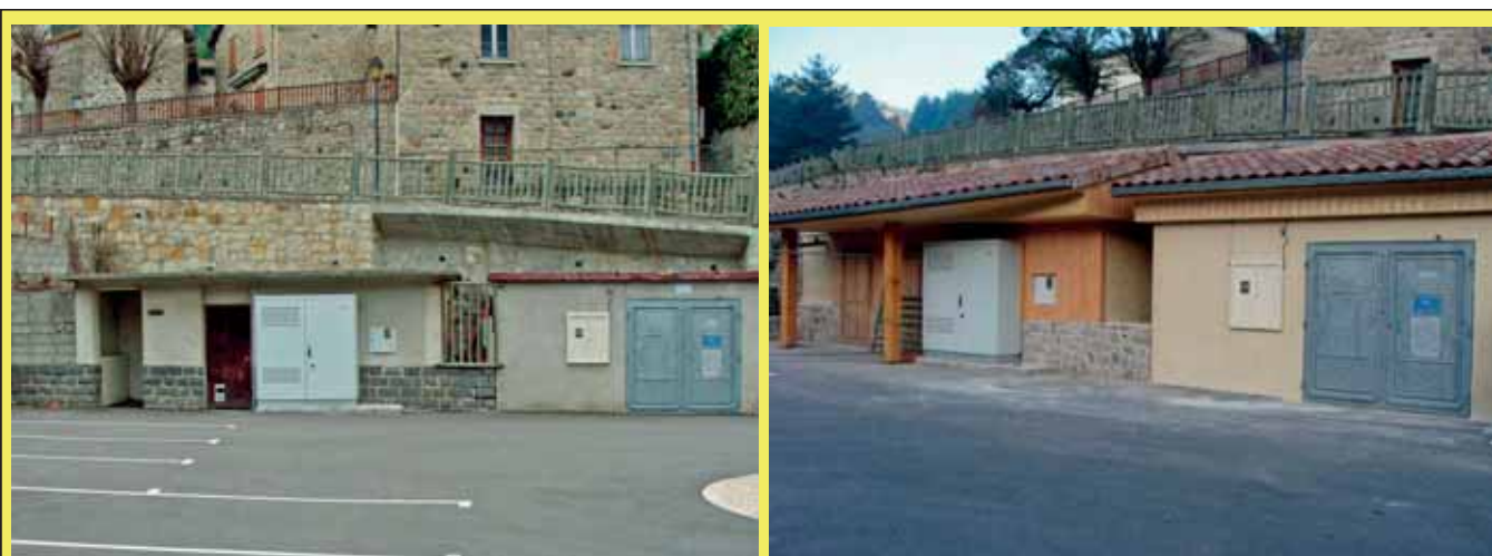
Pont de Fromentières : WC public et locaux annexes avant et pendant leur rénovation
