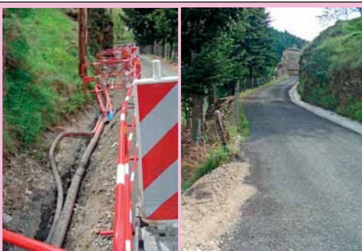
Garnier : l'enfouissement des réseaux secs EDF (par le S.D.E) et téléphone. La chaussée et le caniveau terminés.
