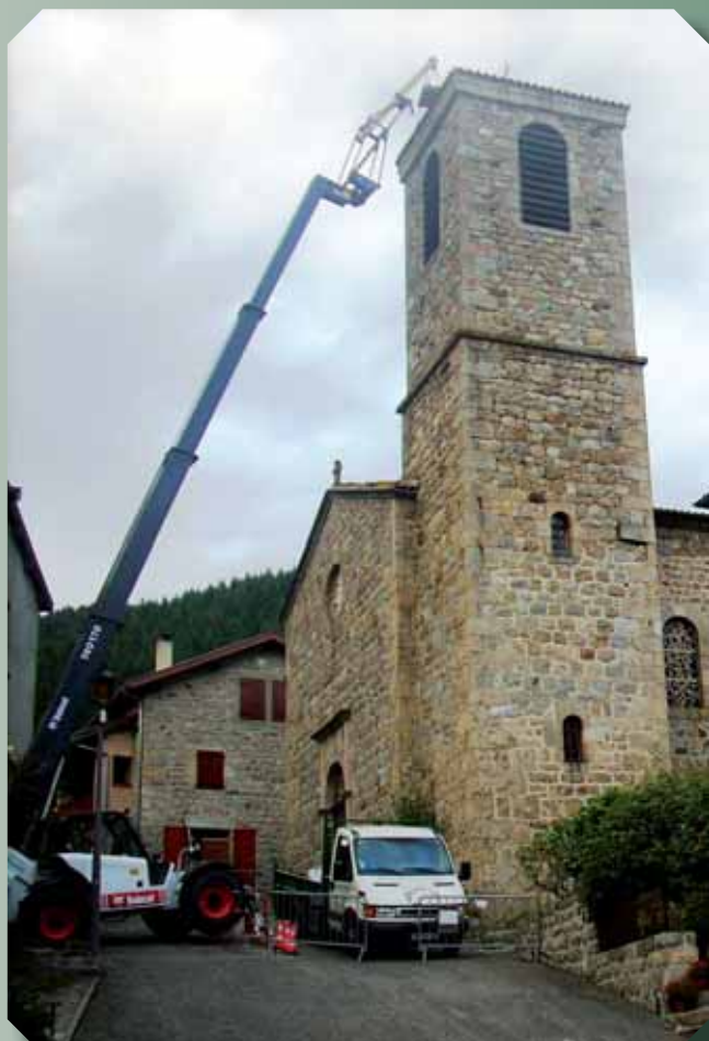
Les travaux de l'église
