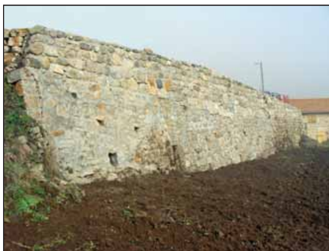
Le mur reconstruit à Chadenac
