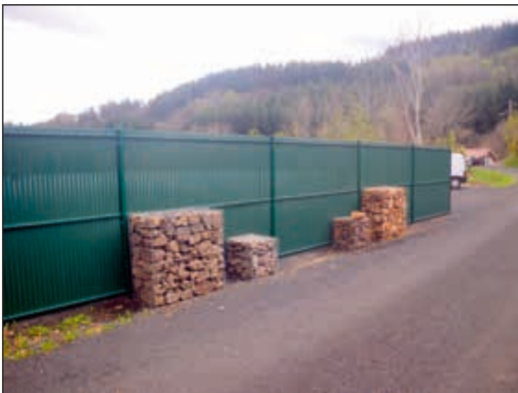
Devant les occultants, qui recevront bientôt des posters dans le cadre de la mise en place du géosite, l'association des Amis de Girond est à l'initiative de la pose de gabions. Ils sont garnis d'un échantillonnage de roches provenant du secteur qui atteste de la richesse géologique visible à Mariac.
