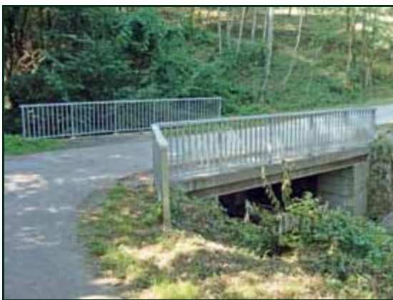
La nouvelle barrière du pont de Fournet.
