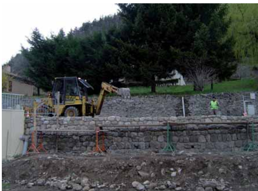
Rénovation et reconstruction du mur à proximité de la mairie
